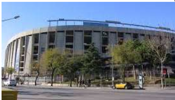
esterno dello Stadio
